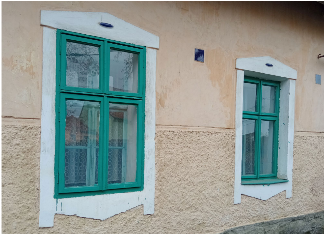
Detail špaletových oken obytného stavení, které pocházejí z přestavby z 20. let 20. století.
