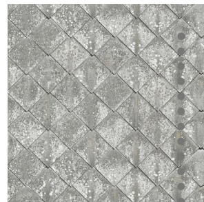
Stávající krytina Eternit Lokálně vyměněn
