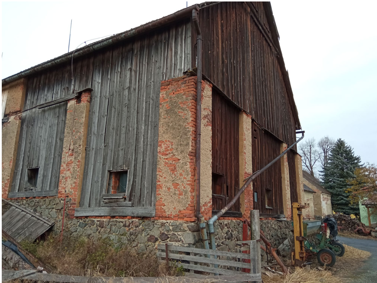
Západní strana stodoly s dřevěným krytím.
