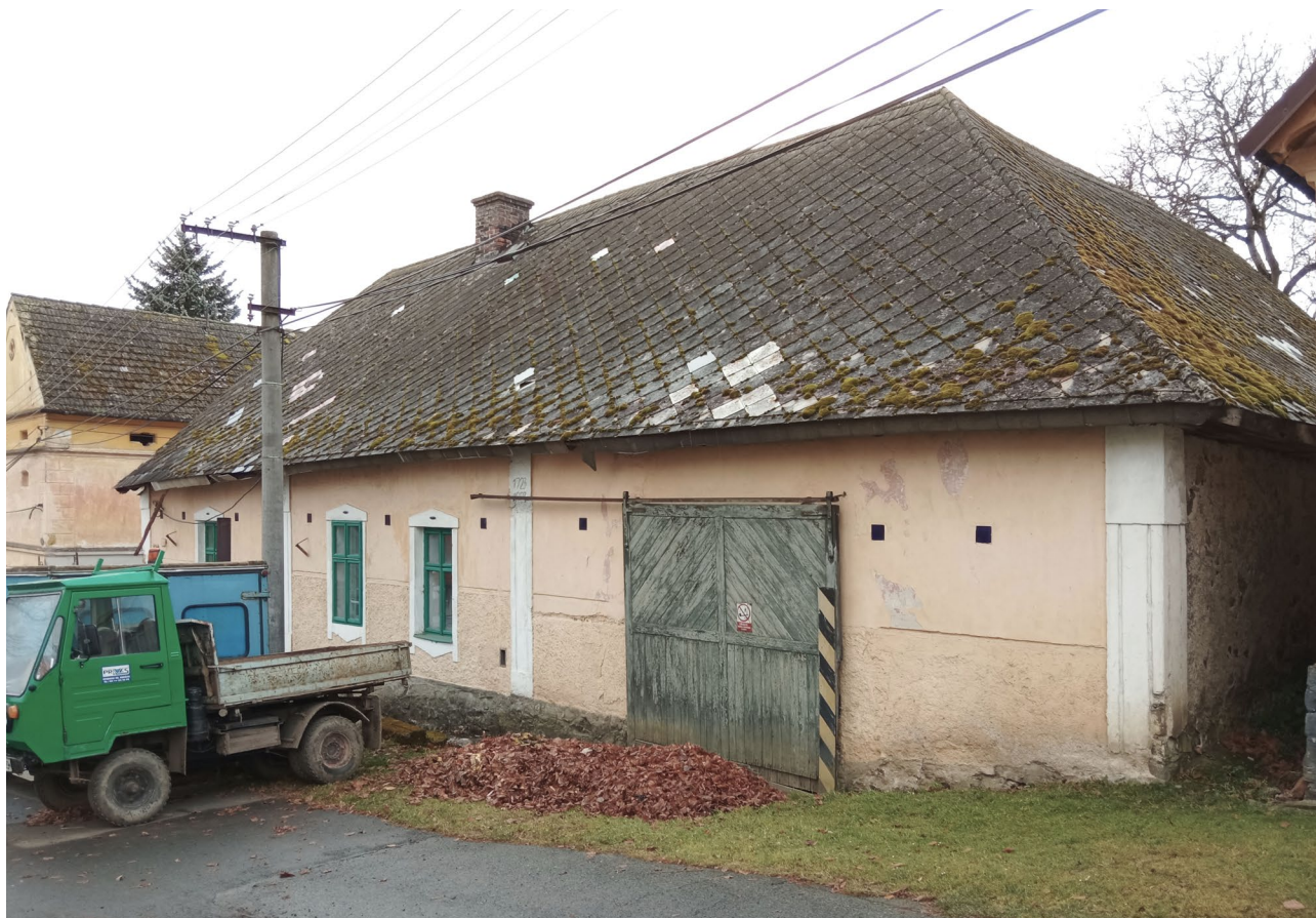
Obytné stavení s vjezdem do stájí.
